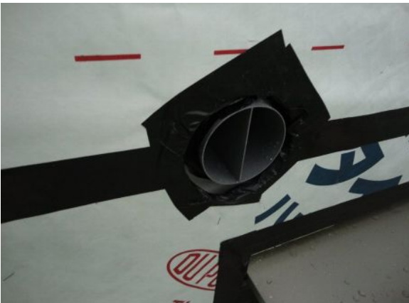
⑤防風・防水シートと設備開口周りのテーピング。
