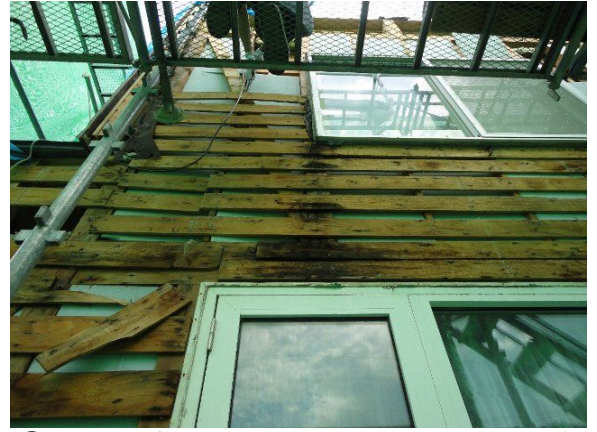
②モルタル撤去後、モルタル下地のバラ板がかなり傷んでいました。
