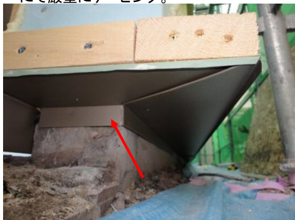
⑥水切り下端部分にテーピングが出て来るので下端鉄板をL型に曲げ劣化防止を施した。
