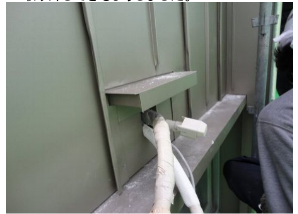
⑭空調の冷媒管の出口に小さな底をつけました
