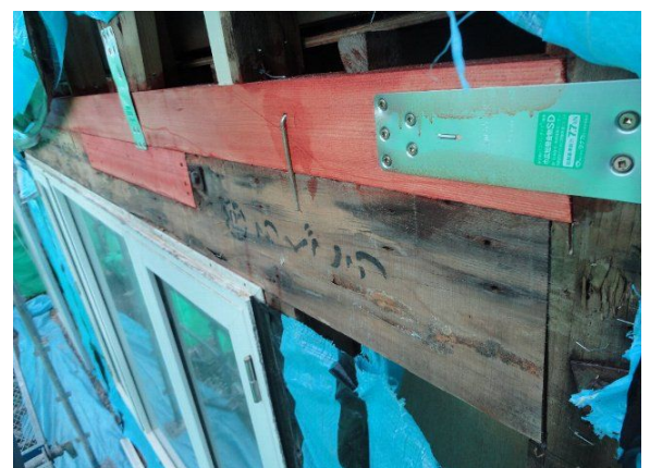
⑧梁の補修と補強を行った状況。土台・柱・梁の補修は合計4箇所にとんだ。
