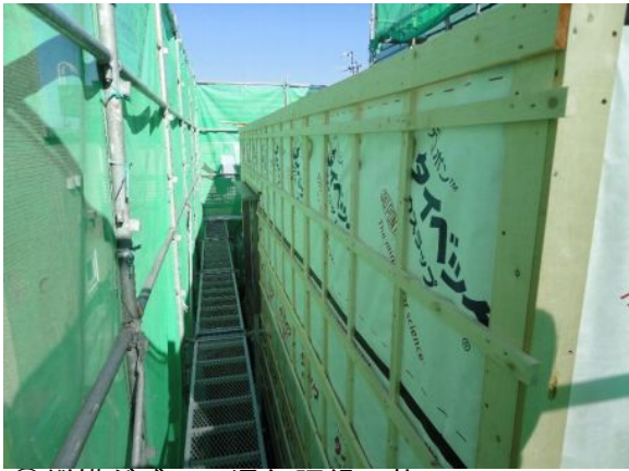
⑨縦横ダブルの通気胴縁の施工。
