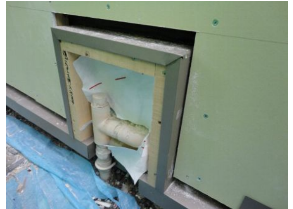
⑫ガス配管の導入部分。将来の改修時に取り外しできるようにしました。
