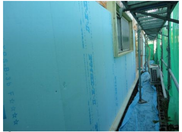
②発泡断熱材の貼り付け。
