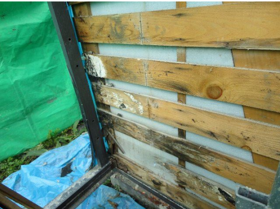
③鉄骨のテラスが取り付けいていた部分。金物の接続部から水が入っていたようです。
