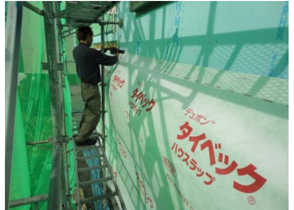
④防風・防水シート貼り。
