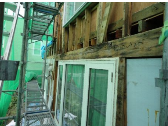
⑦窓上の梁の損傷状況。(大工さんによるとこの家の腐食部はかなり少ないとのことでした。)
