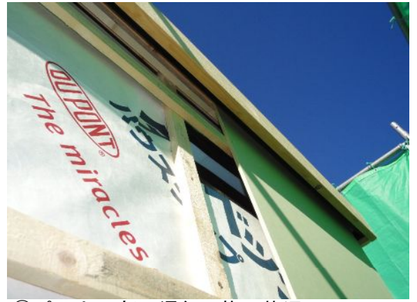
⑩パラペット部の通気の施工状況。
