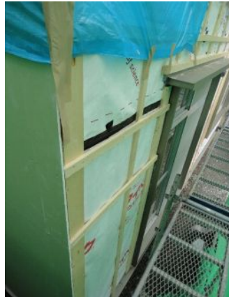
⑪通気胴縁の上に耐水プasterボード貼り。
