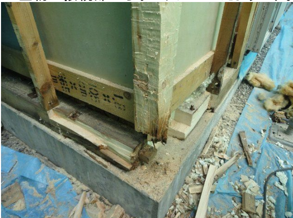
⑤土台と柱の補修工事中。
