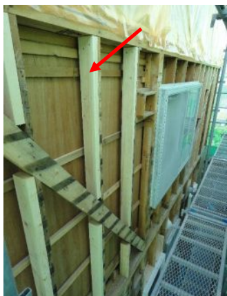
①間柱の補強をし、構造用合板を張ることで耐震性能のアップをはかりました。
