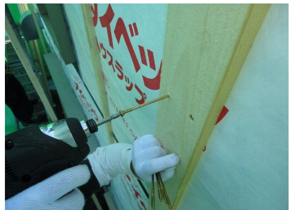
⑧この断熱ビスにより、柱・間柱・構造用合板を貼った本体構造と断熱材が一体化し、構造強度が増します。
