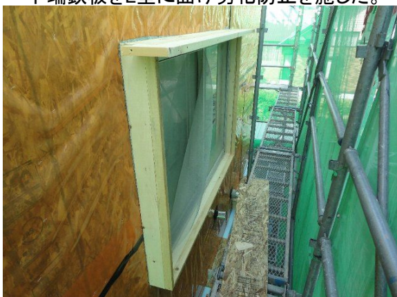
⑧サッシュ周りの枠下地と底下地の取付。
