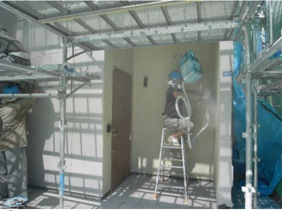
①外壁モルタルの撤去作業。
