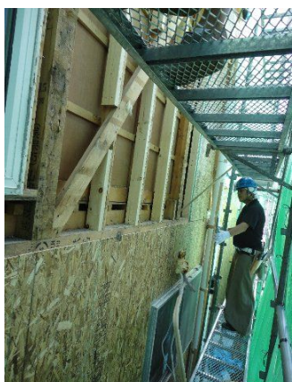
①間柱の補強をし、構造用合板を張ることで耐震性能のアップをはかりました。
