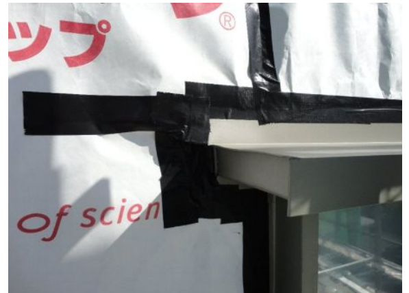
⑥窓枠周りの役物板金とシートのテーピング。
