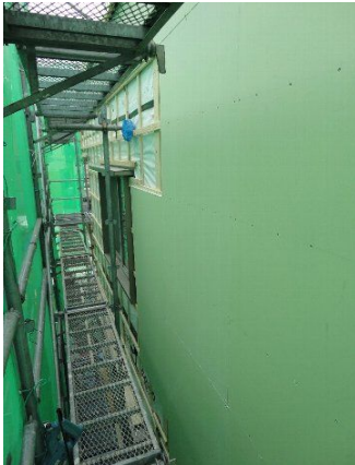
⑪通気胴縁の上に耐水プasterボード貼り。
