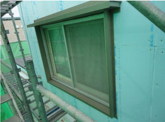
③窓枠周りの役物板金の取付。
