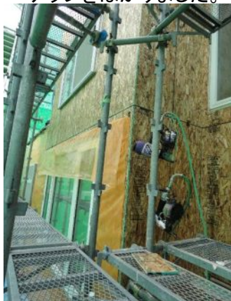
③構造用合板の外側にポリフィルムにて防湿シートを施工。
